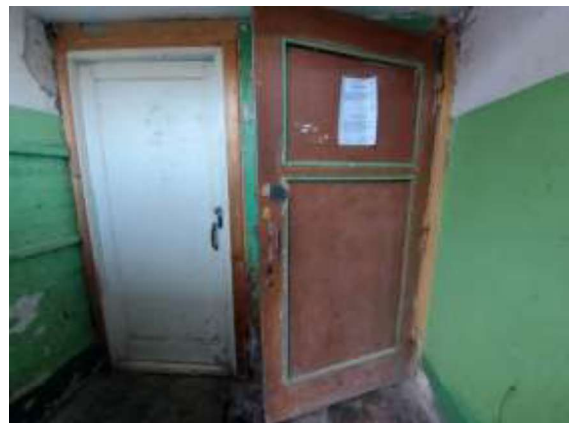
Ieeja kāpņu telpa
